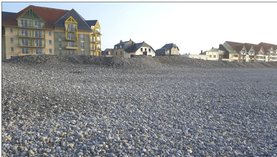
☞ Cayeux, le 16 janvier 2018 : la digue de galets vue de la mer.
