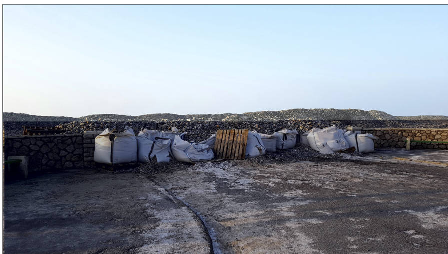
— Cayeux, le 16 janvier 2018 : des big bags renforcent la digue pour protéger la ville de la submersion marine.
