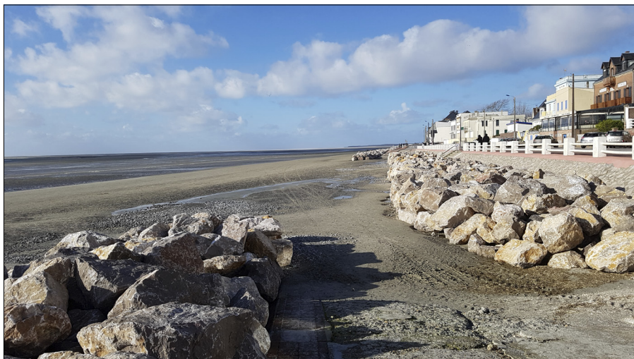
☞ Enrochements au Crotoy à l'entrée de la digue Jules-Noiret, le 1 er février 2018.
